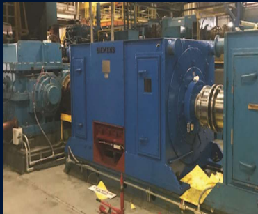
Actuator on Site
